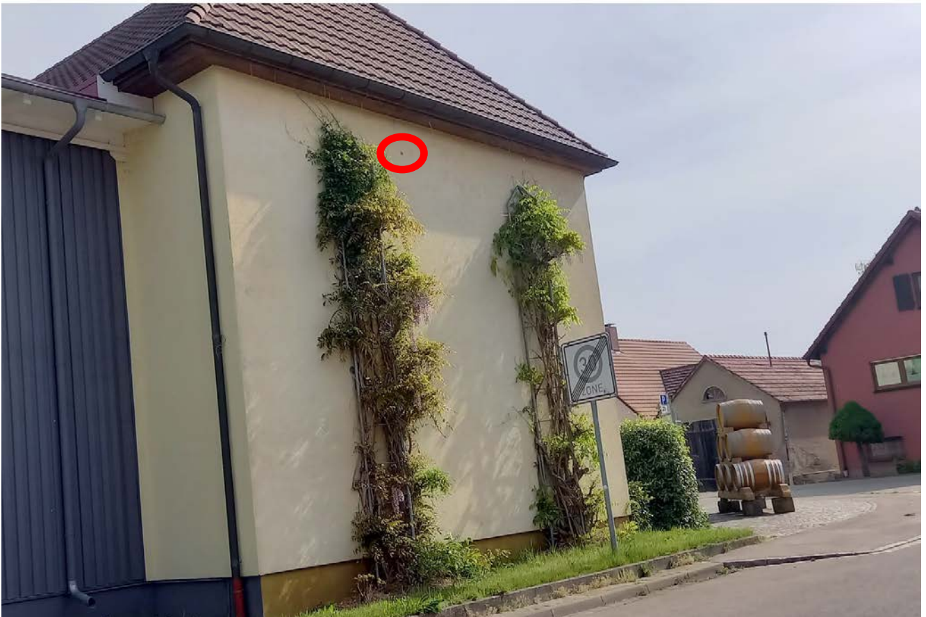
Abbildung 7: Nest einer fassadenbewohnenden Faltenwespe am Gebäude der Winzergenossenschaft Hügellheim.
