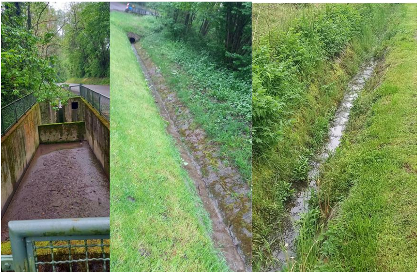
Abbildung 6: Bilder des Grabens entlang der Hollbergstrae. Oberer Abschnitt mit Tosbecken (links), mittlerer Abschnitt (mitte) und unterer Abschnitt am Rande des Planbereichs (rechts).
